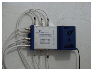
Abbildung 5 - Einspeisung am Multiswitch
